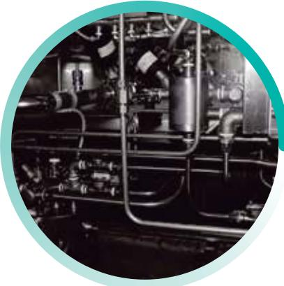
El sistema está diseñado para desconectar el agua desmineralizada y proteger así la funcionalidad del pico de presión del suministro de agua. En efecto, este sistema, según el agua industrial y/o la materia tratada, transporta el agua a un depósito antirretorno abierto y la devuelve a presión atmosférica, para evitar el reflujo en la línea de suministro.
